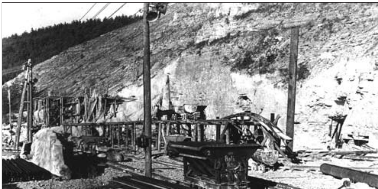
Dieses Photo zeigt einen Teil des Baustellengeländes vor den Stollengruppen 16 bis 25. Die Aufnahme soll angeblich im Herbst 1945 angefertigt worden sein.
