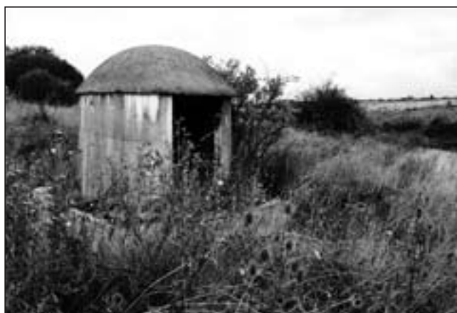
Das Eingangsbauwerk des unterirdischen Nachrichtenamtes 10 auf dem Truppenübungsplatz Ohrdruf, wie es sich noch in der ersten Hälfte der 1990er Jahre zeigte.
