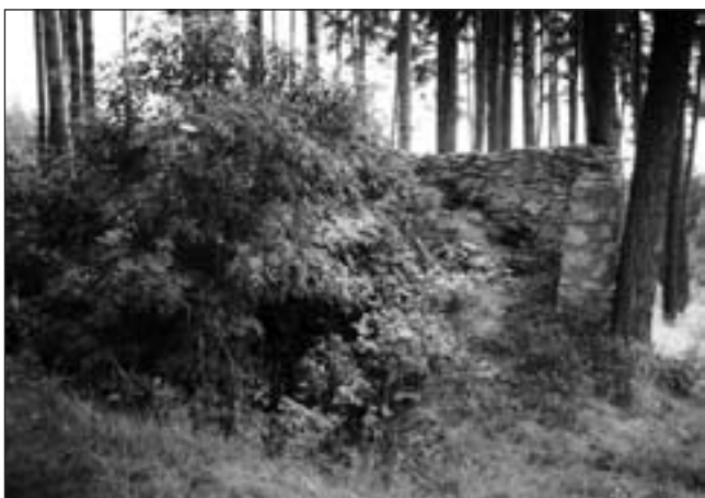
Im Heidenholz, nördlich des Jonastals mit Truppenübungsplatz, gibt es die sogenannte Schießmauer. Der kleine Ruinenrest einer wohl ehemals christlichen Kapelle könnte auch in Hohlräume führen, wie die eingesunkene und zugewachsene Stelle verdeutlicht.
